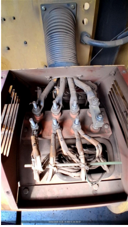
FOTO FECHAMENTO DA BASETA ANTES DE MEGAR
