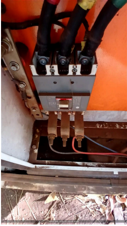
CONEXÃO DOS CABOS NO GERADOR
