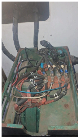
FOTO FECHAMENTO DA BASETA ANTES DE MEGAR
