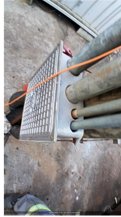
CONEXÃO DOS CABOS NO QUADRO DO CLIENTE
