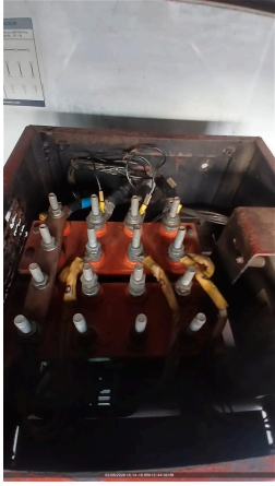
FOTO FECHAMENTO DA BASETA ANTES DE MEGAR
