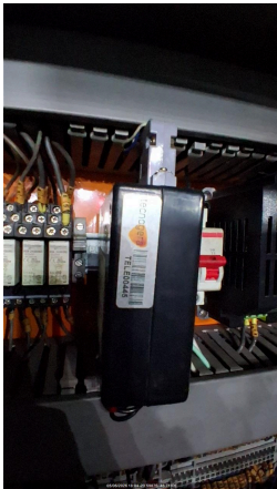
FOTO ANTENA GPS (ANTENA QUADRADA)
