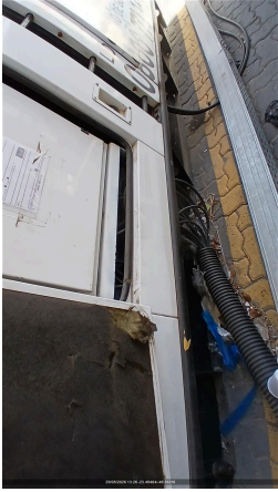
CONEXÃO DOS CABOS NO GERADOR
