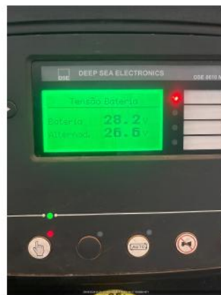
FOTO DO TESTE COM CARGA
