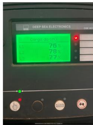
FOTO DO TESTE COM CARGA
