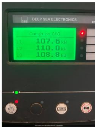
FOTO DO TESTE COM CARGA
