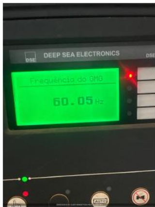
FOTO DO TESTE COM CARGA
