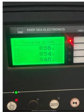
FOTO DO TESTE COM CARGA
