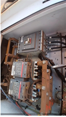
CONEXÃO DOS CABOS NO GERADOR
