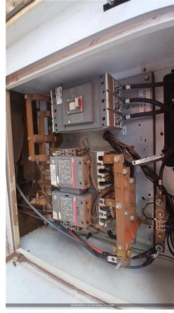
CONEXÃO DOS CABOS NO QUADRO DO CLIENTE
