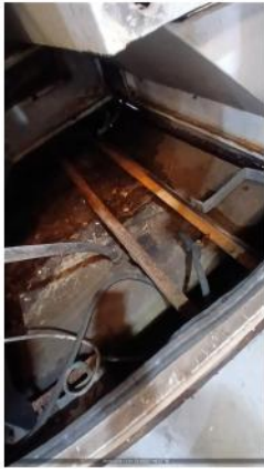
FOTO DA BATERIA
