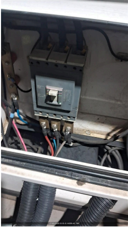
CONEXÃO DOS CABOS NO GERADOR
