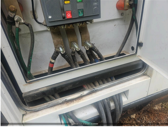
CONEXÃO DOS CABOS NO GERADOR
