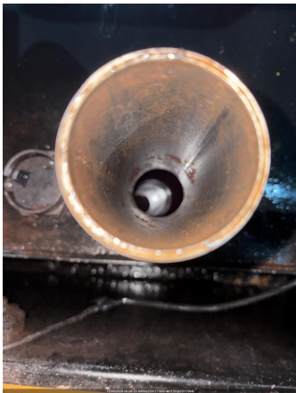
FOTO DO TANQUE INTERNO (DENTRO)
