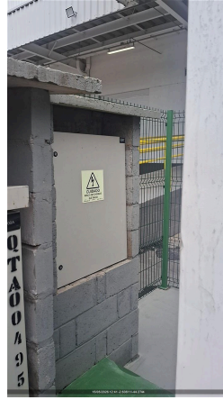
CONEXÃO DOS CABOS NO QUADRO DO CLIENTE
