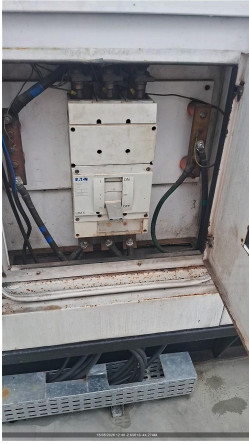
CONEXÃO DOS CABOS NO GERADOR
