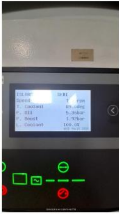
FOTO DO TESTE COM CARGA
