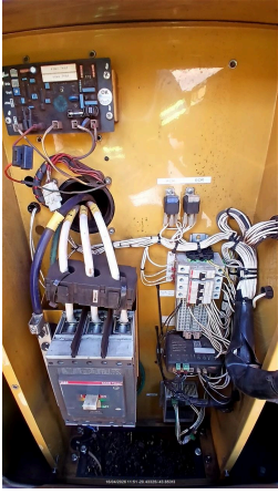
CONEXÃO DOS CABOS NO GERADOR
