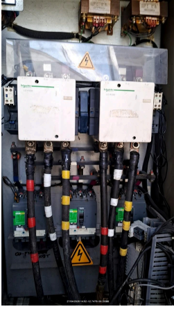
CONEXÃO DOS CABOS NO GERADOR
