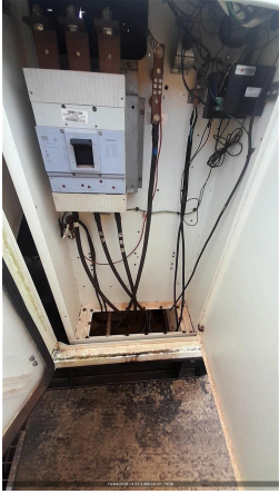
CONEXÃO DOS CABOS NO GERADOR
