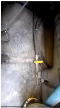
FOTO DO TANQUE INTERNO (DENTRO)
