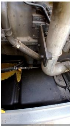
FOTO DO TANQUE INTERNO (DENTRO)
