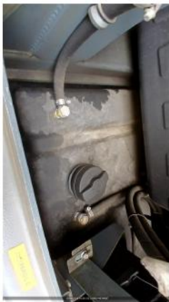
FOTO DO TANQUE INTERNO (DENTRO)
