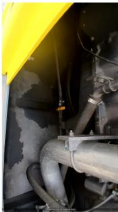
FOTO DO TANQUE INTERNO (DENTRO)
