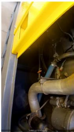
FOTO DO TANQUE INTERNO (DENTRO)
