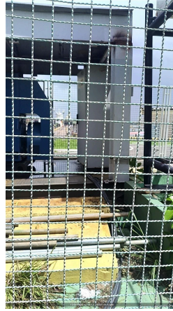
CONEXÃO DOS CABOS NO QUADRO DO CLIENTE
