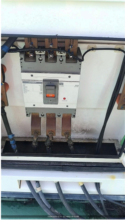
CONEXÃO DOS CABOS NO GERADOR
