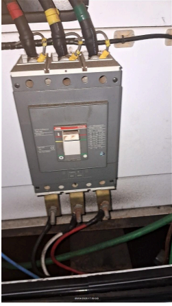
CONEXÃO DOS CABOS NO GERADOR
