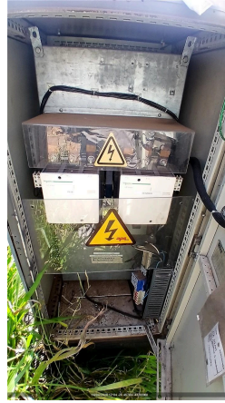
CONEXÃO DOS CABOS NO QUADRO DO CLIENTE
