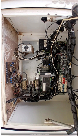
CONEXÃO DOS CABOS NO GERADOR
