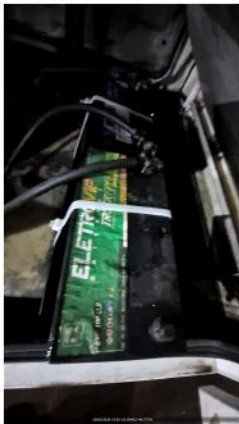
FOTO DA BATERIA
