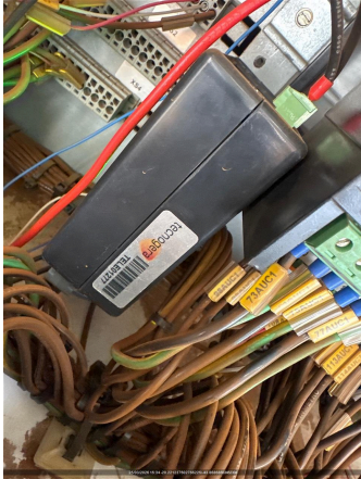
FOTO DOS LEDS DO MODEM (TODOS DEVERIAM ESTAR ACESOS E SEM PISCAR)
