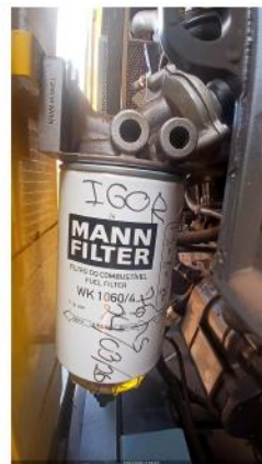
FOTO DA MARCAÇÃO DA DATA DA TROCA NO FILTRO SEPARADOR DE ÁGUA
