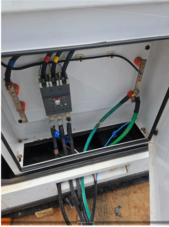
CONEXÃO DOS CABOS NO GERADOR
