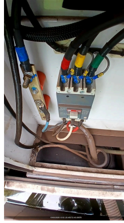
CONEXÃO DOS CABOS NO QUADRO DO CLIENTE
