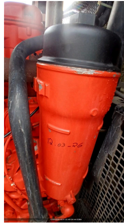
REALIZADO TROCA DO FILTRO DE ÁGUA NÃO SE APLICA
