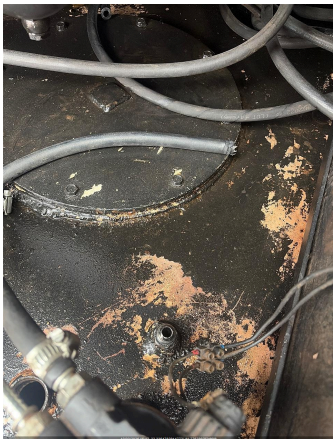
FOTO DO TANQUE INTERNO (DENTRO)
