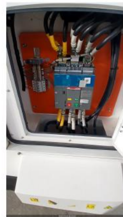
ATUAÇÃO DO DISJUNTOR, PELO CONTROLADOR E MANUAL OK
