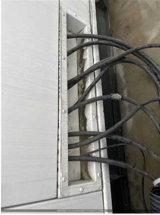
CONEXÃO DOS CABOS NO GERADOR
