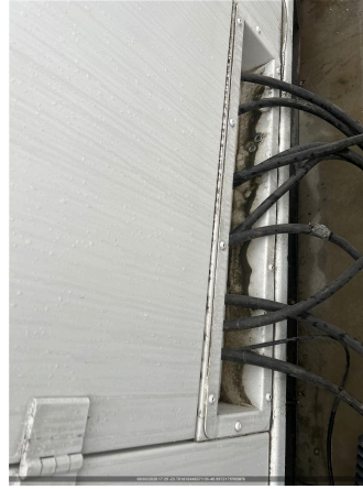
CONEXÃO DOS CABOS NO QUADRO DO CLIENTE
