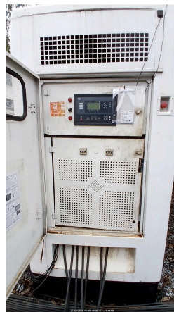
CONEXÃO DOS CABOS NO QUADRO DO CLIENTE
