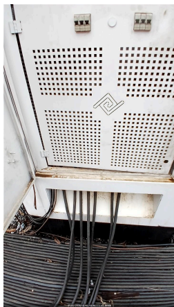
CONEXÃO DOS CABOS NO GERADOR
