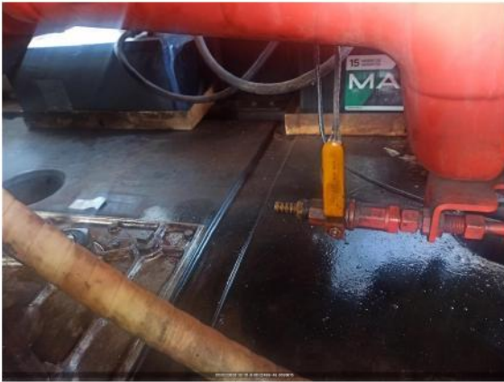
FOTO DO TANQUE INTERNO (DENTRO)
