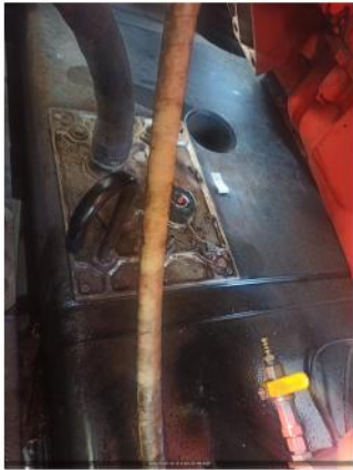
FOTO DO TANQUE INTERNO (DENTRO)
