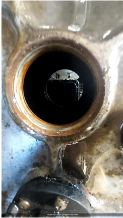
FOTO DO TANQUE INTERNO (DENTRO)
