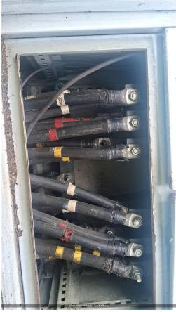
CONEXÃO DOS CABOS NO GERADOR
