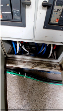
CONEXÃO DOS CABOS NO GERADOR
