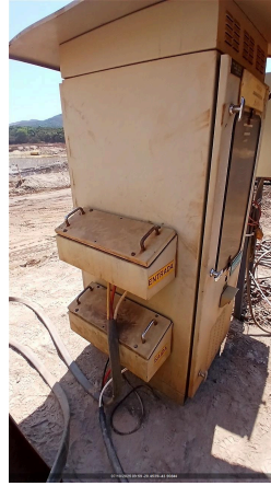
CONEXÃO DOS CABOS NO QUADRO DO CLIENTE
