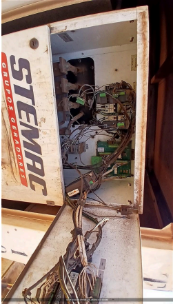
CONEXÃO DOS CABOS NO GERADOR
