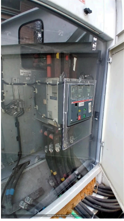
CONEXÃO DOS CABOS NO GERADOR
