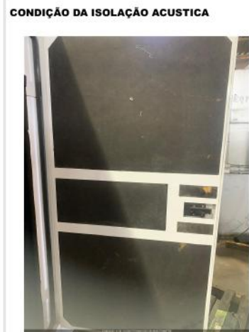
5 - F038 - PRÉ LOCAÇÃO DE GERADOR
